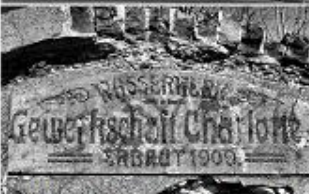
28. Wieża ciśnienia i napis nad wejściem do stacji pomp.
